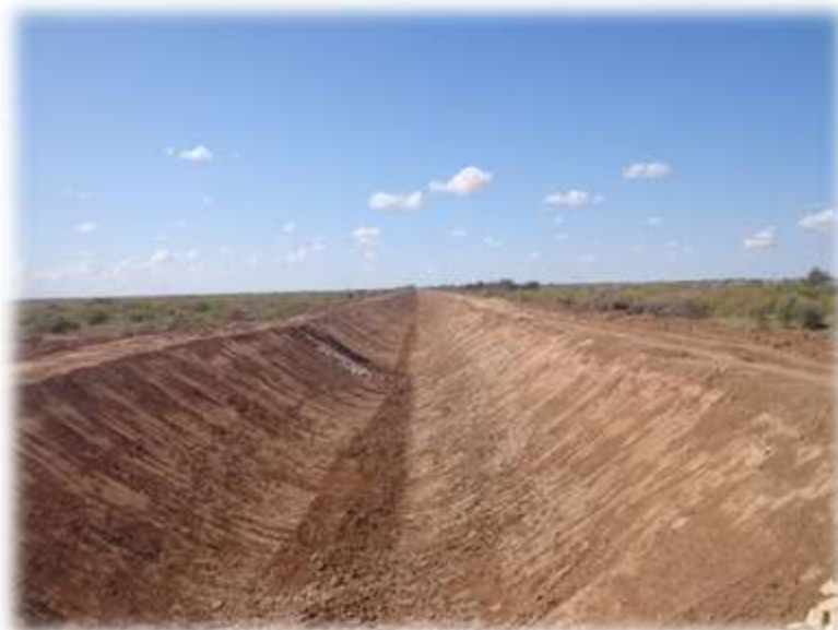
Очистка Яшкульского распределительного канала от наносов и заиления
