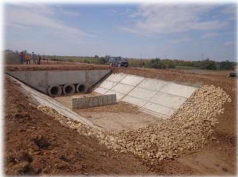
Подпорное сооружение на ПК304+40 Яшкульского распределительного канала
